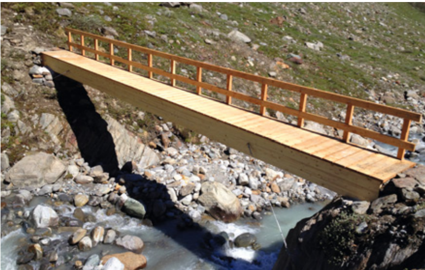
Unten: Zum Schutz vor Lawinen und Schmelzwasser müssen viele Brücken jedes Jahr ab- und wieder aufgebaut werden
